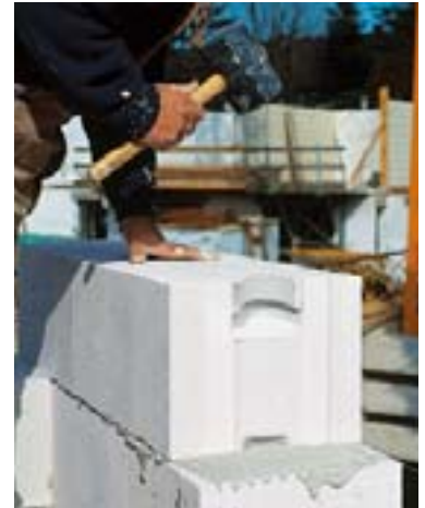
Bild 2.10: Ausrichten von Porenbetonsteinen
