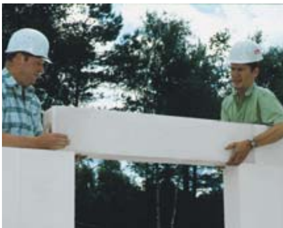
Bild 3.3: Aufsetzen eines HN Sturzes
