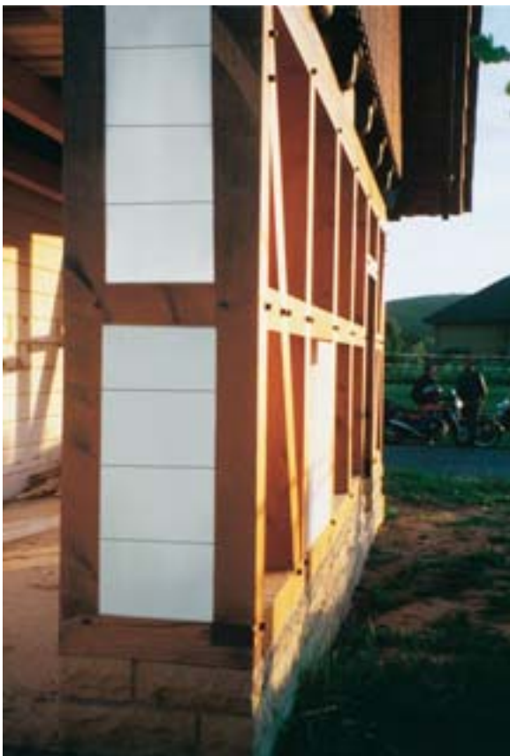
Bild 5.8: Ausgemauertes Fachwerk
