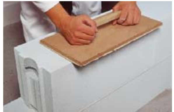
Bild 5.3: Bearbeiten mit Schleifbrett
