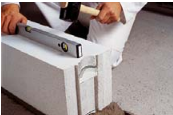
Bild 5.2: Ausrichten der ersten Schicht
