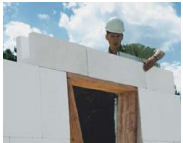
Bild 3.4: Ausrichten von HN U-Schalen
