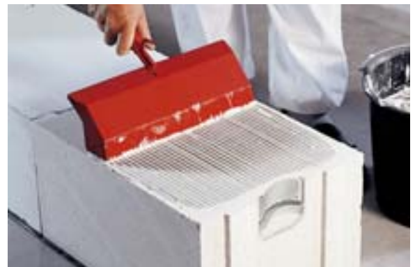
Bild 5.4: Auftragen von Dünnbettmörtel
