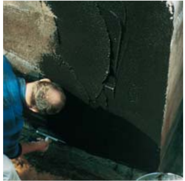
Bild 5.7: Kelleraußenwand mit Bitumendickbeschichtung
