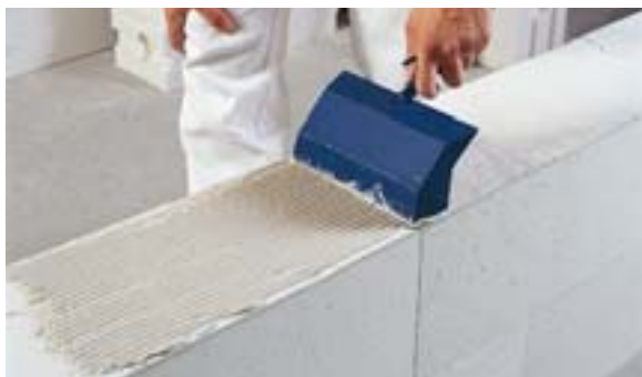
Bild 2.5: Aufziehen des Dünnbettmörtels
