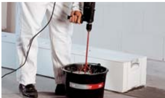
Bild 2.4: Anmischen des Dünnbettmörtels
